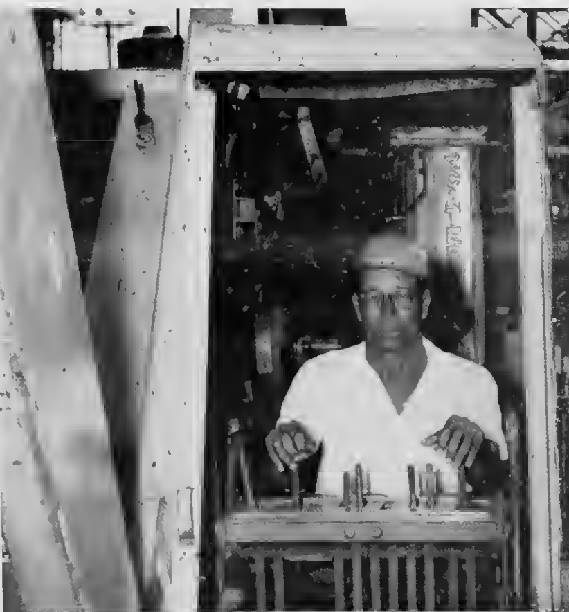
ERASMUS at controls of crane F-15 guides free end of stack. ERASMUS na controlnan di grua F-15 ta guia e punta suelto di e staca.
